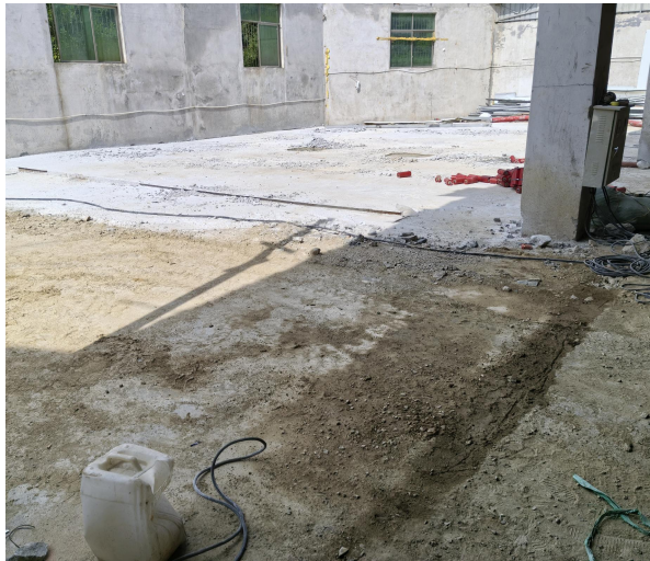
厂区现场照片
