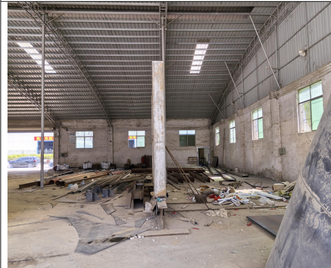
厂区现场照片
