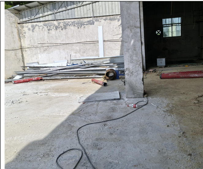
厂区现场照片
