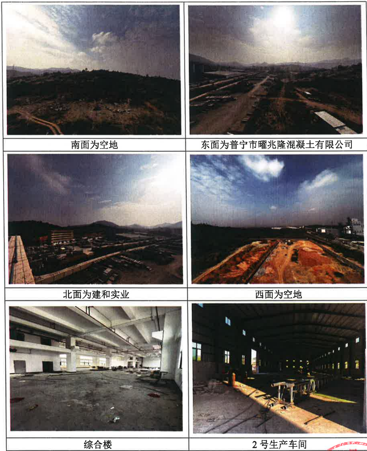
附图 4 项目四至情况及厂内现状照片
