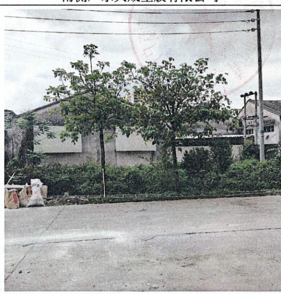
北侧闲置工业厂房
